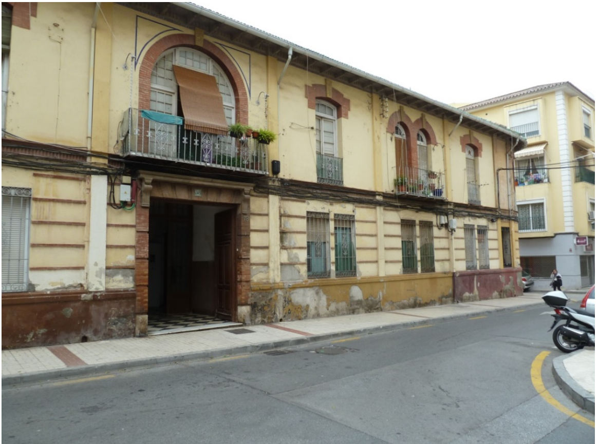
Fotografías del estado actual
