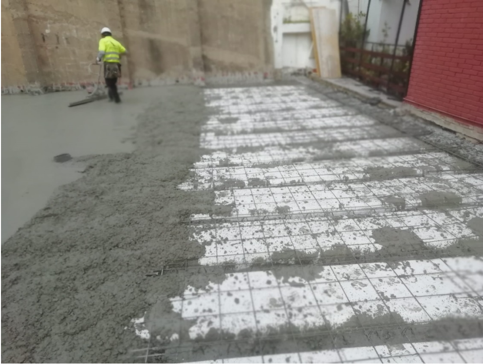
Imagen hormigonado forjado A
