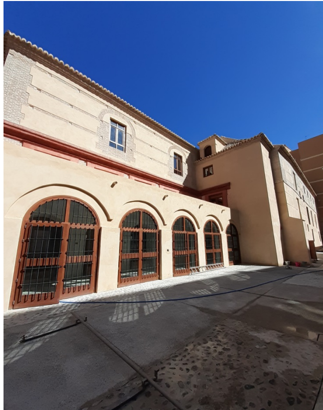
Fachada calle Eslava
