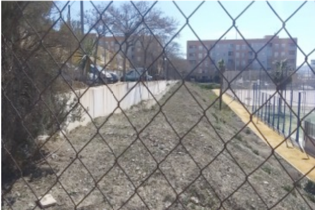
Calle Holanda - Barriada Intelhorce – Expte 2022
