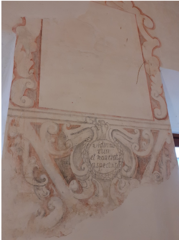
Pintura mural en zona escalera principal
