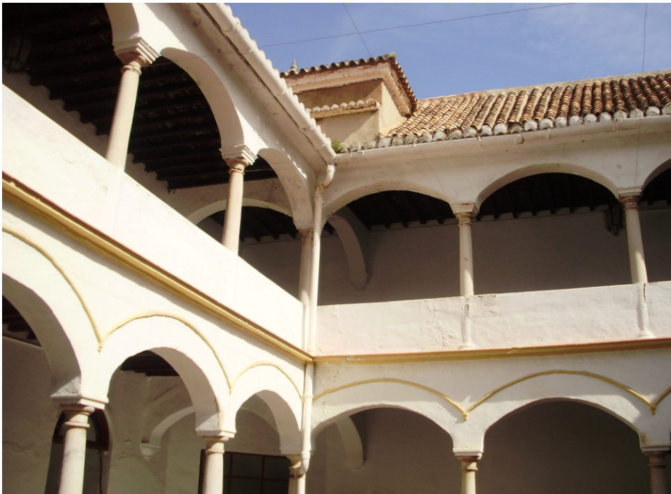
Vista actual del claustro.
