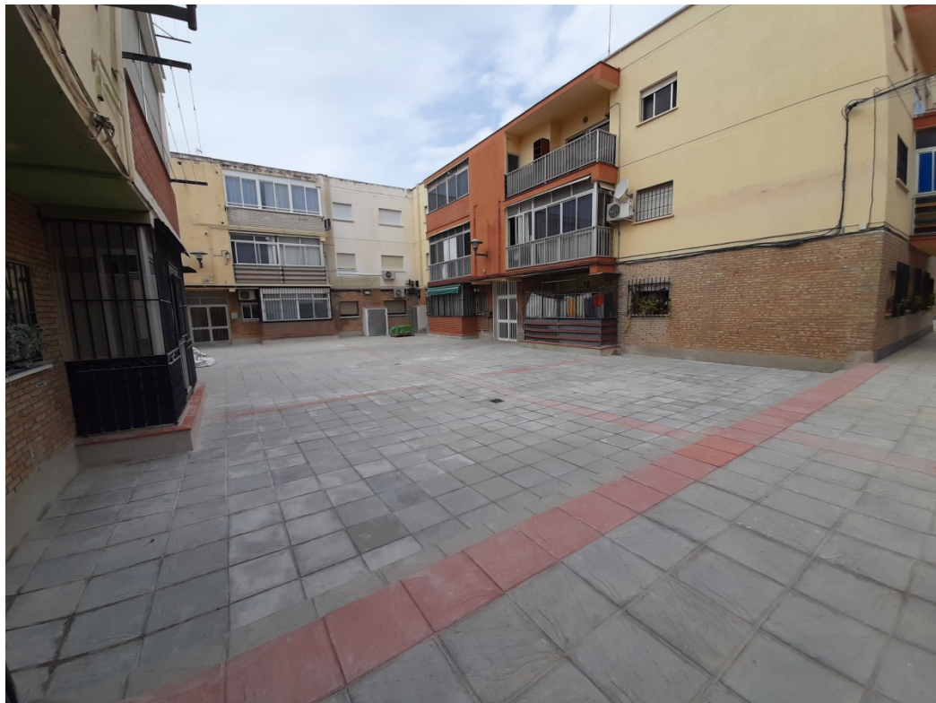
Imagen finalización trabajos forjado B
