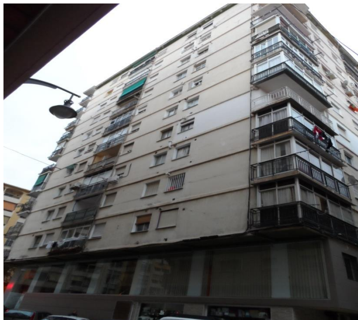
Fachada C/ Asturias nº 1
