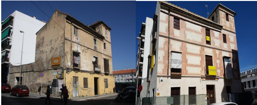
Estado inicial y final
