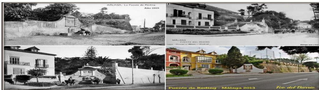
Estado anterior a la intervención
