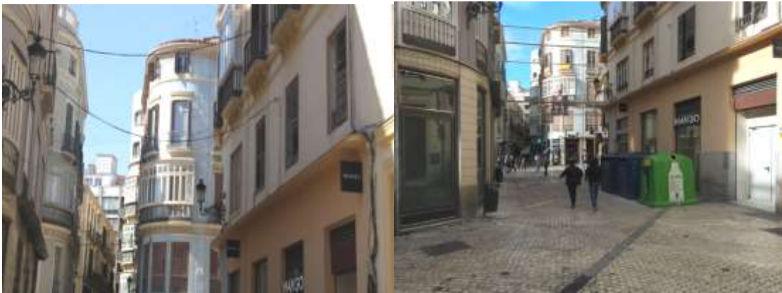
Estado inicial y final C/ Bolsa nº 1
