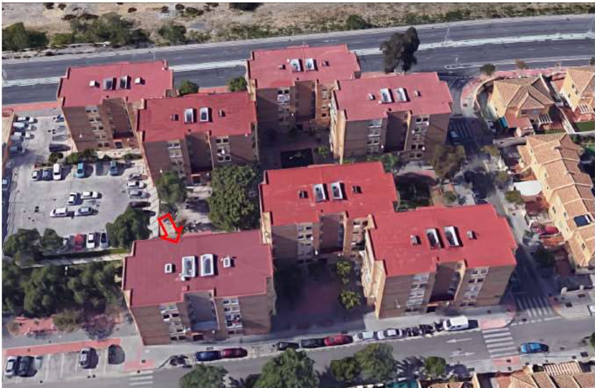
Vista aérea Este. Fuente: Google Maps
