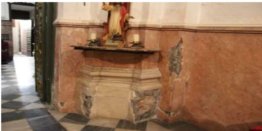
Zócalo mármol rosa recibido con mortero rico en cemento
