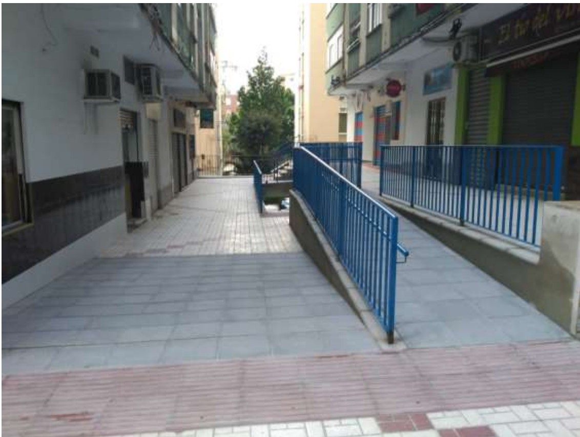
Estado final Pasaje Vigil Escalera y Pasaje Ministerio de la Vivienda
