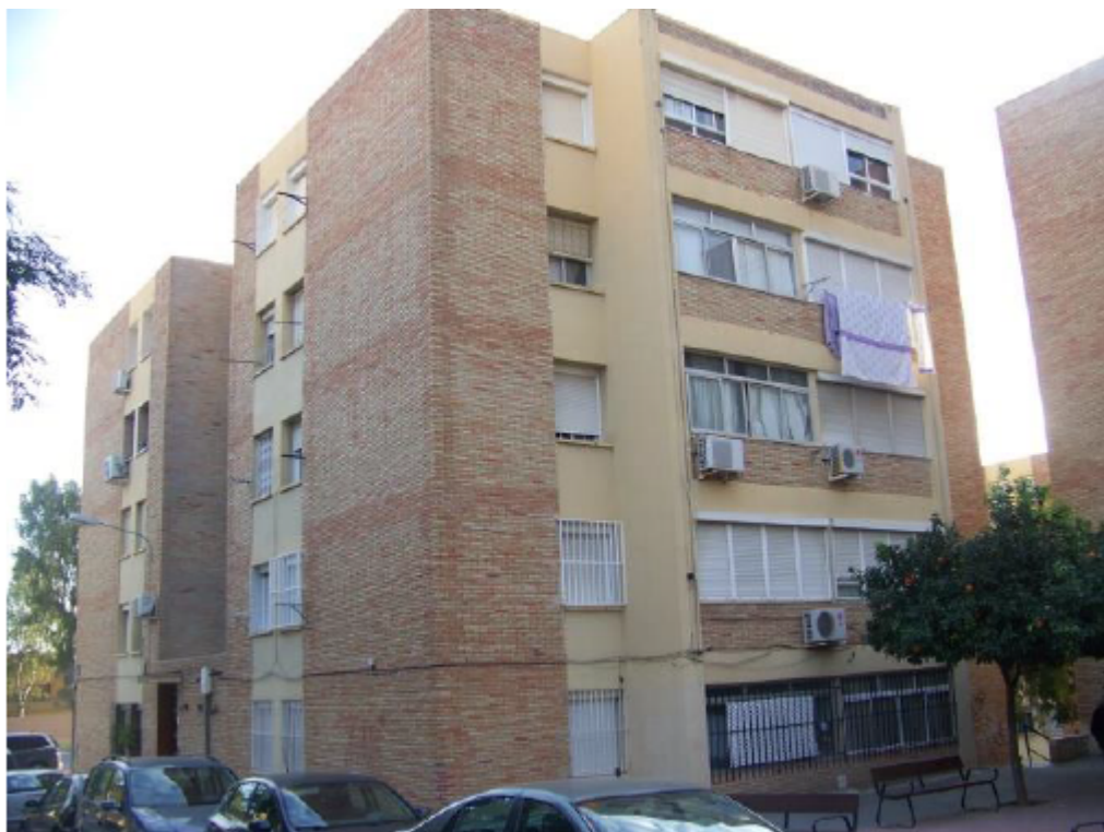
Fachada del edificio sito en C/ Jose María Jacquard nº 16.
