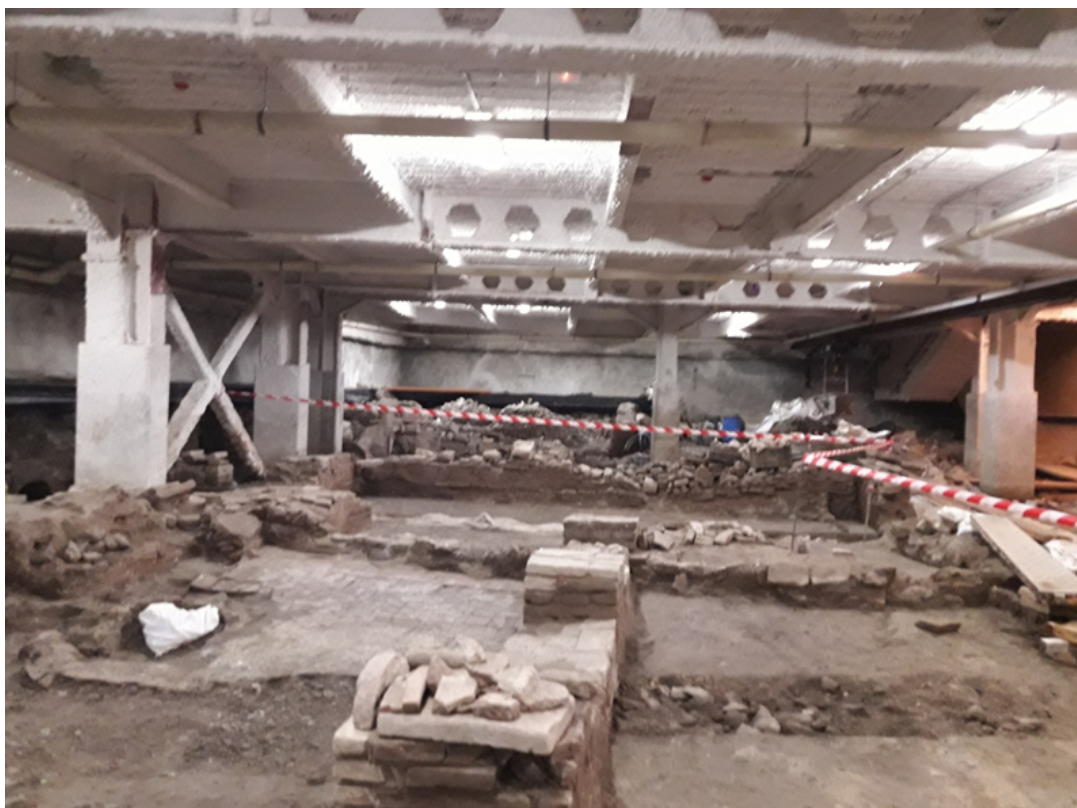
Estado actual del sótano.
