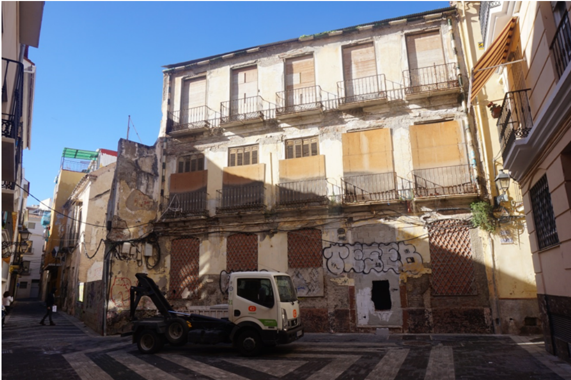
Detalle estado actual de los inmuebles.
