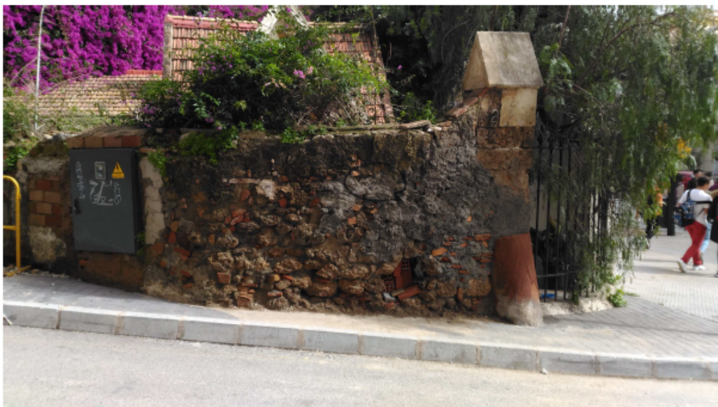
Foto nº6: Vista del perímetro desde calle Ibarra
